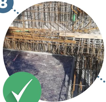
Coffrage du plancher en même temps que la pose des poutres pour remplissage en sécurité
