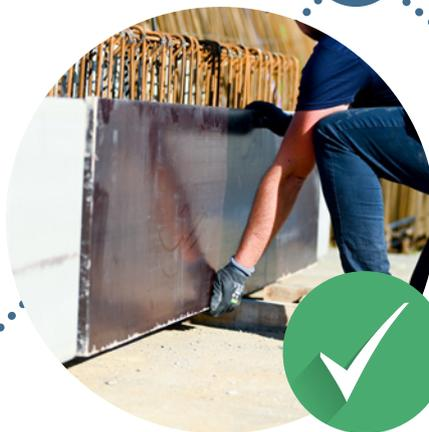
Si vous constatez l'apparition de fissures sur les pô au droit du talon (partie coulée préfa), prévoir le renforcement avant coulage avec une planche et serre joint sur le talon
