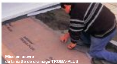
Mise en œuvre de la natte de drainage TROBA
